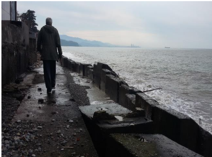
ამორტიზირებული ნაპირდამცავი კედელი
