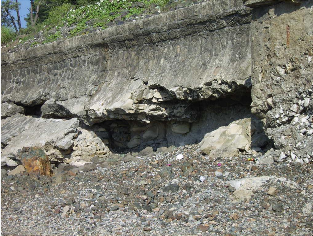
მწვანე კონცხი. რკალის პროფილის კედლის დაზიანებული უბანი
