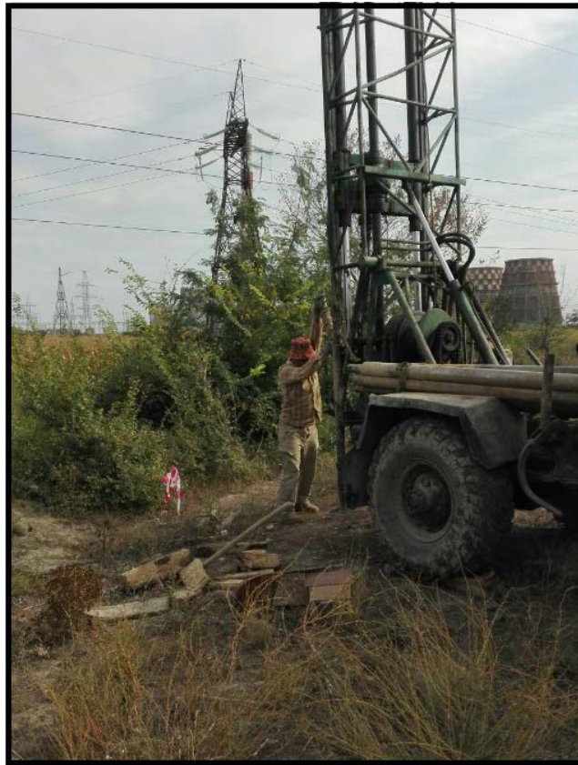
ბურღვითი სამუშაოები ელექტროგადამცემი ხაზის დერეფნის გასწვრივ.
