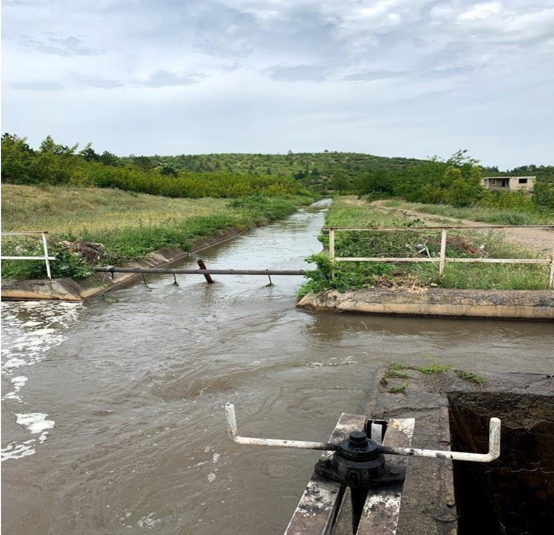
სურათი 62: სარწყავი ქსელი გამანაწილებელი ფარით
