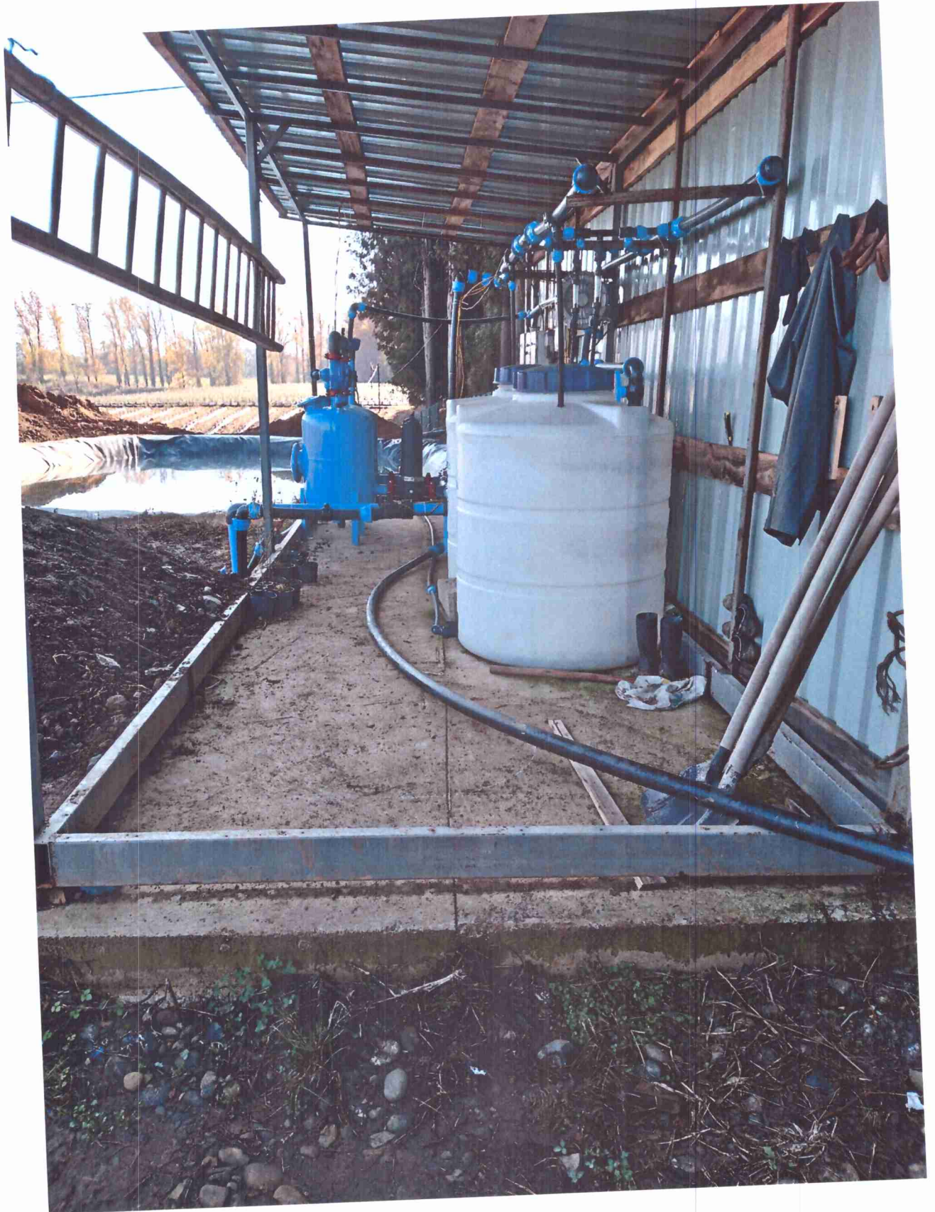
სურ. N2 პლანტაციაზე წყლის სადგური (ტუმბო, ფილტრი)
