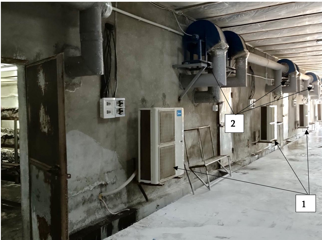
ნახ.7 შპს „მარნეულის სოკო“-ს სოკოს სათბურის გაგრილების სისტემა. 1 - კონდინციონერი; 2 - ვენტილიატორი.
