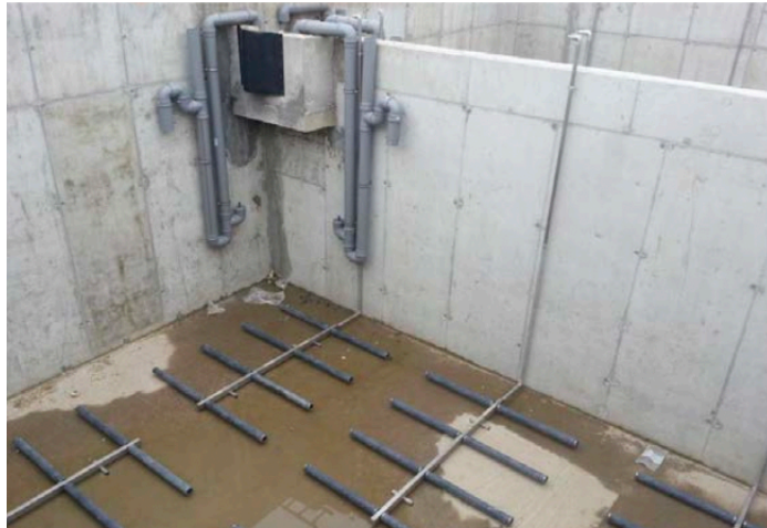
ნახ 5.4. სადგურის შეგთავსის ზოგადი ხედი დიფუზიის ძელაკებითა და პნევმატური ამწის მილებით.
