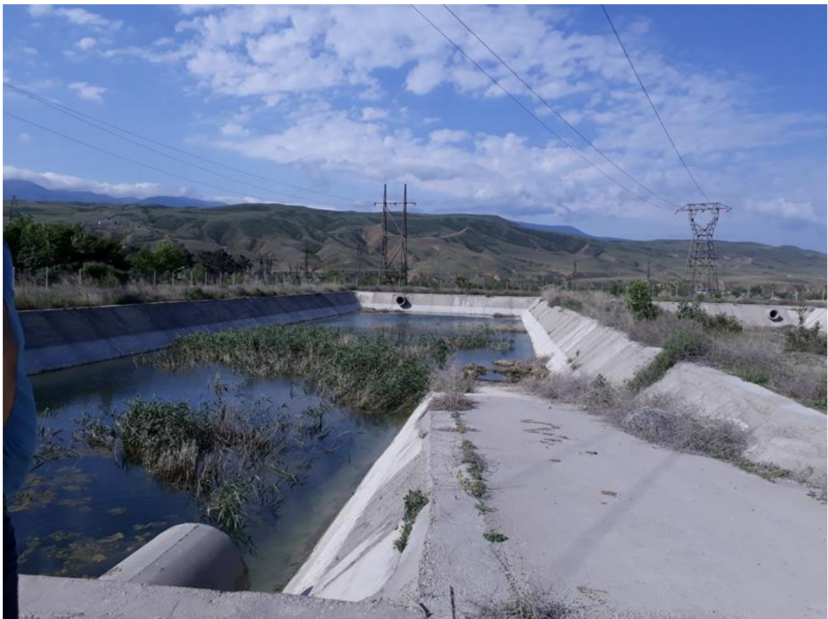
სურ. 7.4.1.1 კასპის ცემენტის ქარხნის სანიაღვრე წყლების გამწმენდი სალექარები
