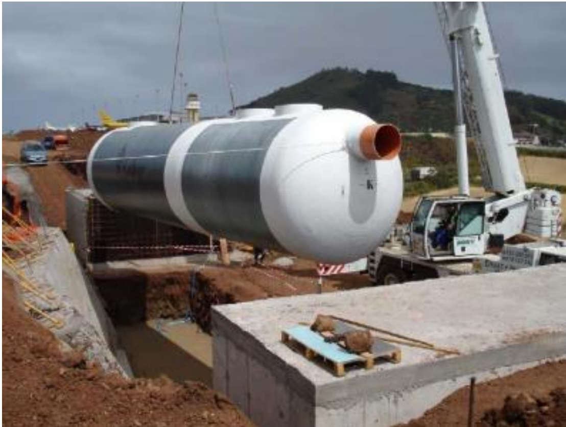
სურათი 7.4.2.1. “SALHER”- ის მარკის კოალესცენტური ნავთობდამჭერი (სეპარატორი),
