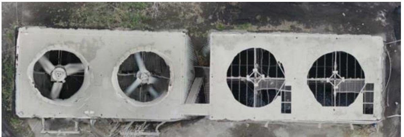
სურათი 2 კასპის ცემენტის ქარხნის შხეფმაცივრები N 1 & 2
