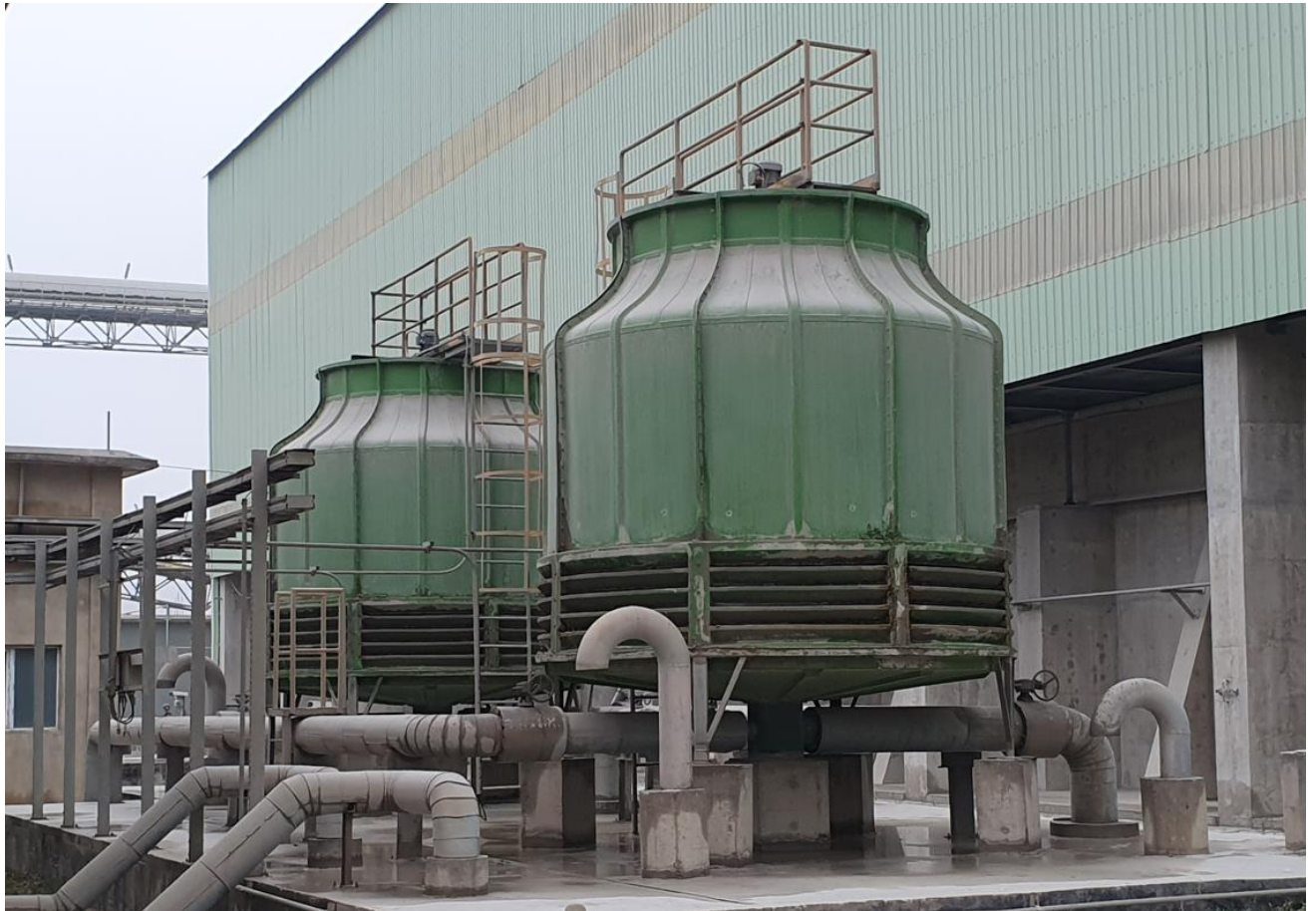
სურათი 3 კასპის ცემენტის ქარხნის შხეფმაცივრები N 3 & 4
