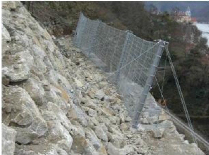
სურათი 3.2.6.6.1.2. ტექნიკური ჩამოშლისგან დამცავი ზღუდე (2,000 კჯ) ბუნებრივ ფერდობზე.
