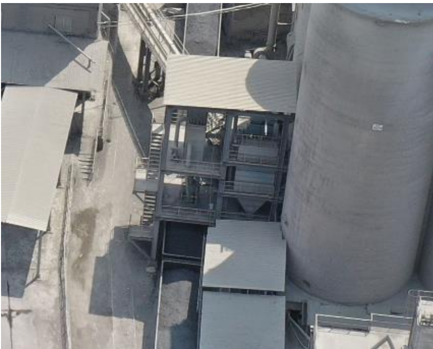
სურათი 15 ცემენტის რკინიგზის ვაგონებში ჩატვირთვის ძირითადი ინფრასტრუქტურა
