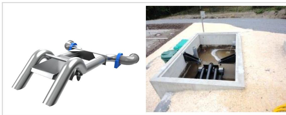
სურათი 2.5.1. ავტომატური რეგულირების სიფონი
