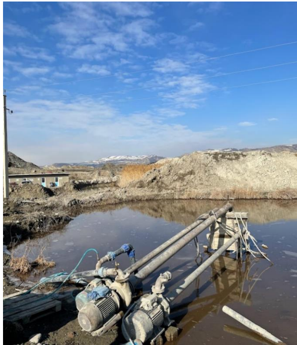
სურ N6.6 - წყლის მიმღები ბასეინი და მასში განთავსებული ტუმბოები
