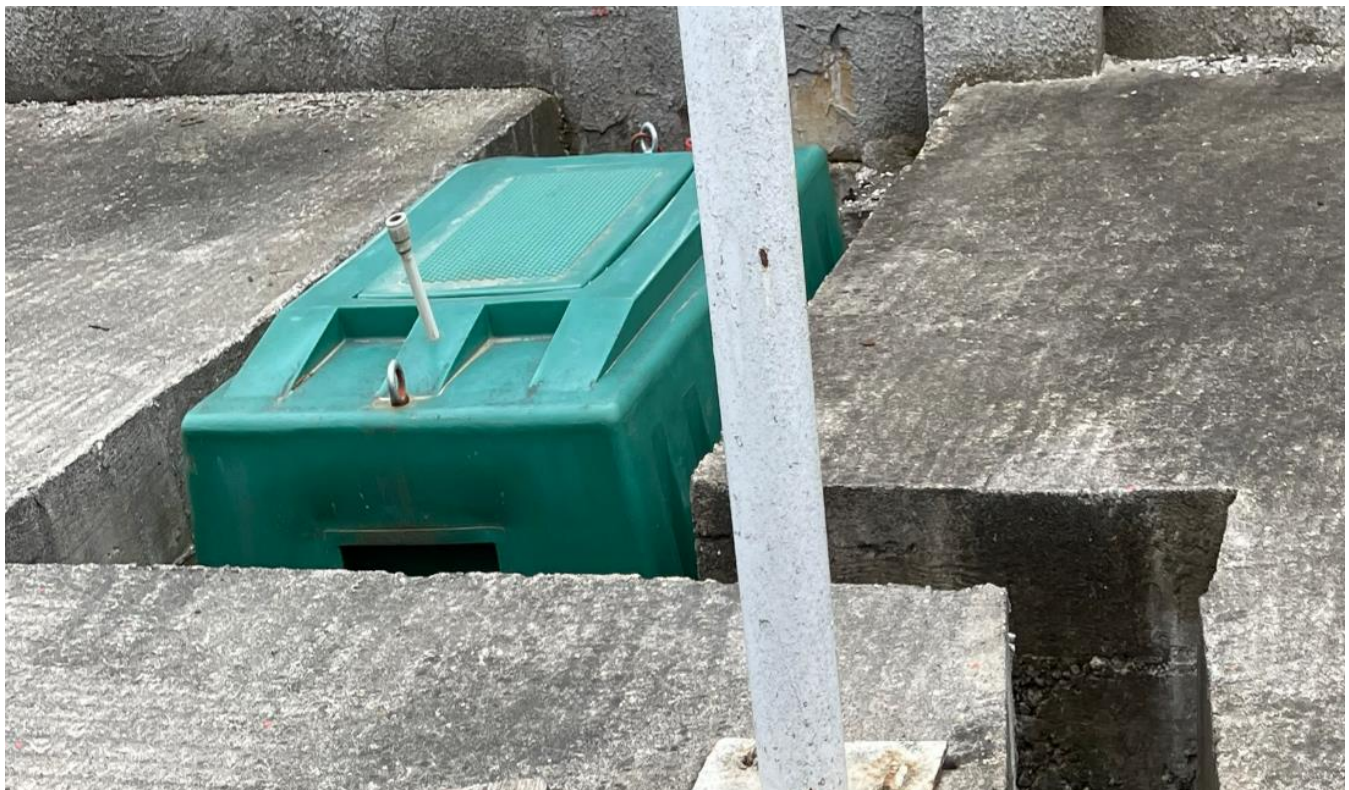
სურათი N15 - ახალი ნავთობდამკერი, სასუნთქი მილით
