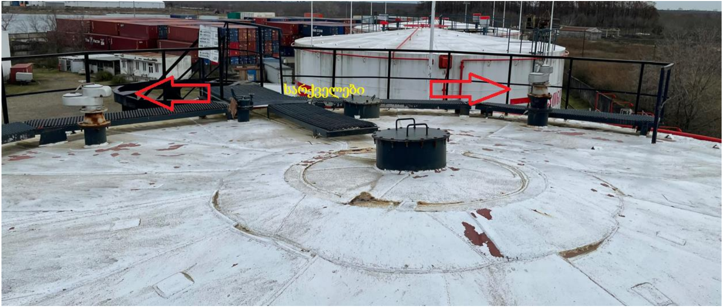
სურათი N11 - მე-3 რეზერვუარზე განთავსებული 2 სარქველი
