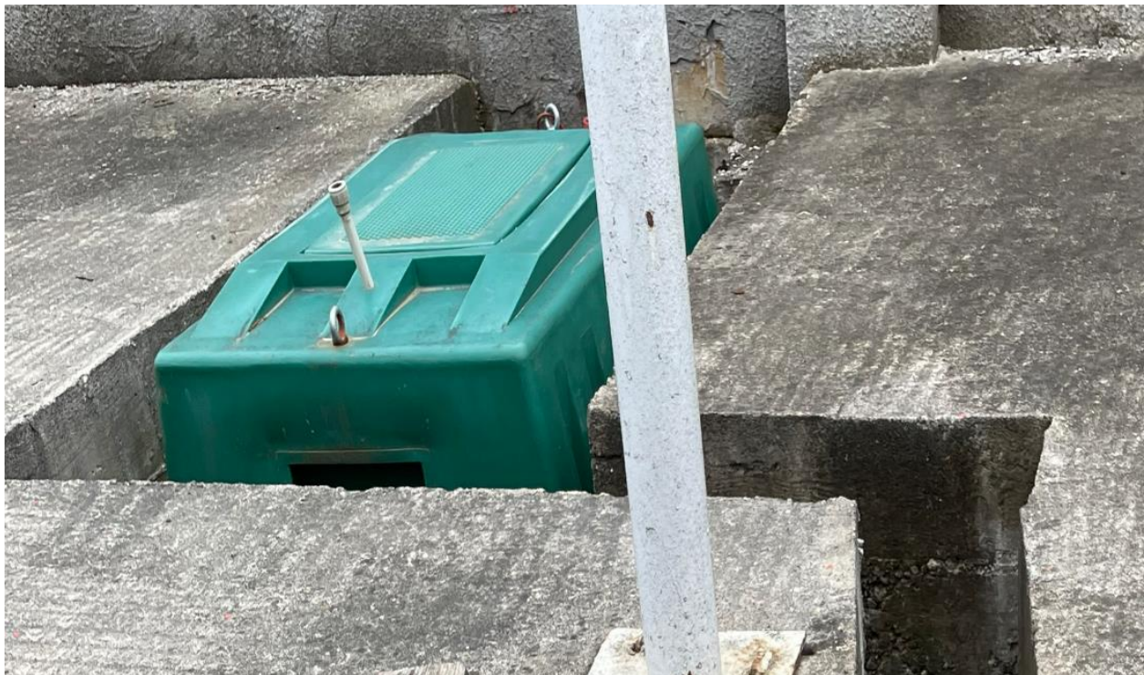
სურათი N8 - ახალი (N2) ნავთობდამჭერი
