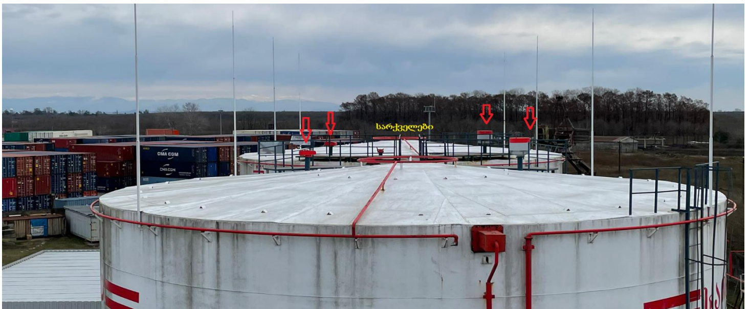
სურათი N10 - მე-4 და მე-5 რეზერვუარებზე განთავსებული 2-2 სასუნთქი მილები (სარქველები)
