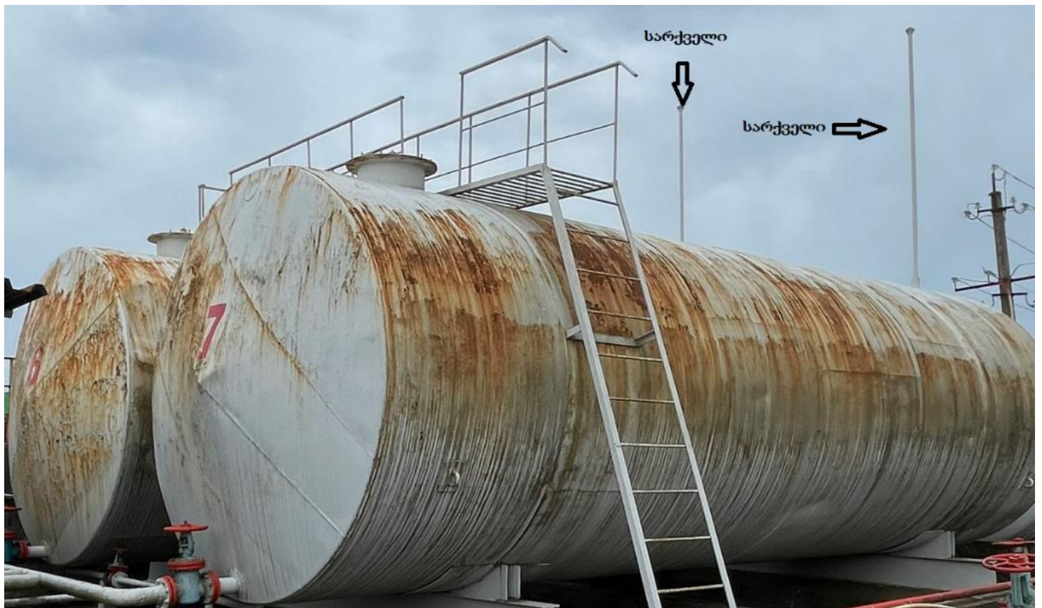
სურათი N14 – N6 და N6 მიწისზედა ჰორიზონტალური რეზერვუარების სარკველები
