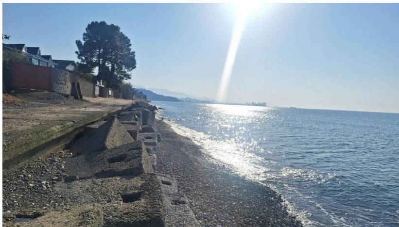
ამორტიზირებული ნაპირდამცავი კედელი 2024წ.
