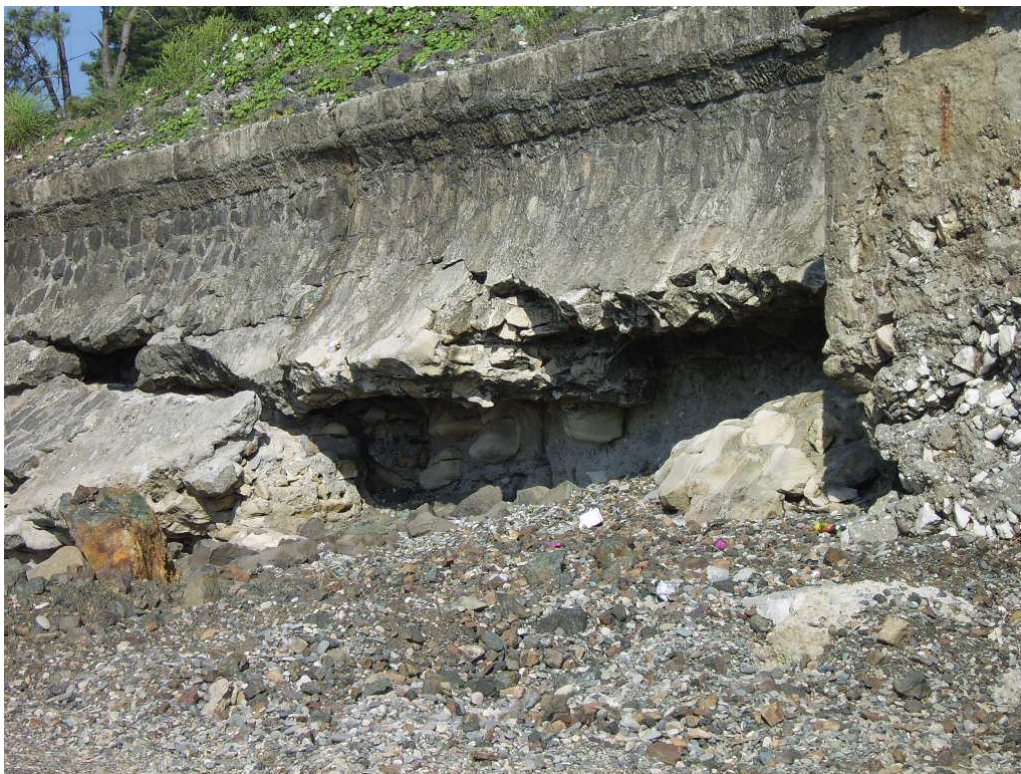
მწვანე კონცხი. რკალის პროფილის კედლის დაზიანებული უბანი
