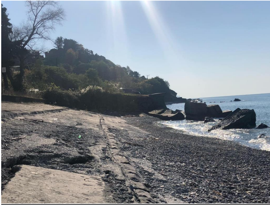
ციხისძირის კონცხი. ამორტიზირებული ნაპირდამცავი კედელი 2024წ.
