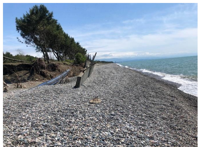
დაზიანებული ბეტონის კედელი 2024 წელი (გაზაფხული)
