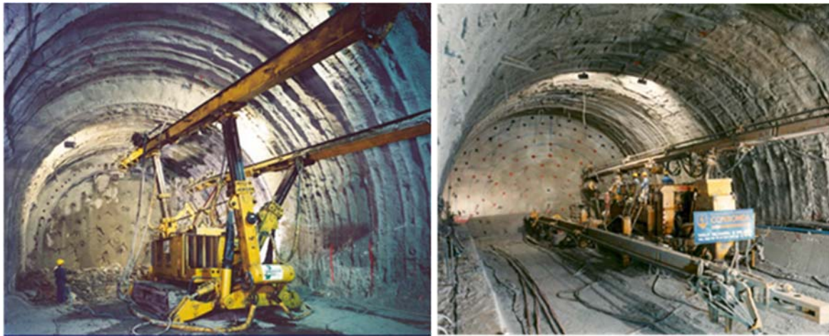
სურათი 28 შუბლის ზედაპირის არმირება მინაბოჭკოვანი კონსტრუქციული ელემენტებით.
