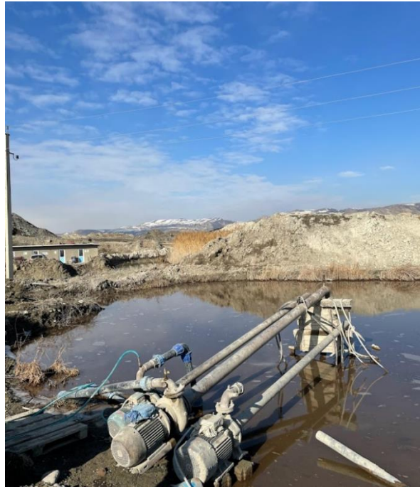
სურ N5.4 - წყლის მიმღები ბასეინი და მასში განთავსებული ტუმბოები
