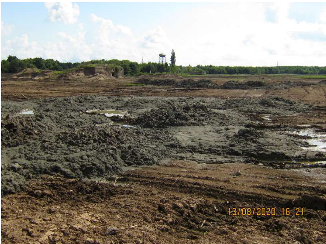
სურათი 8. სამშენელო ტერიტორიის გადათხრილი მონაკვეთი
