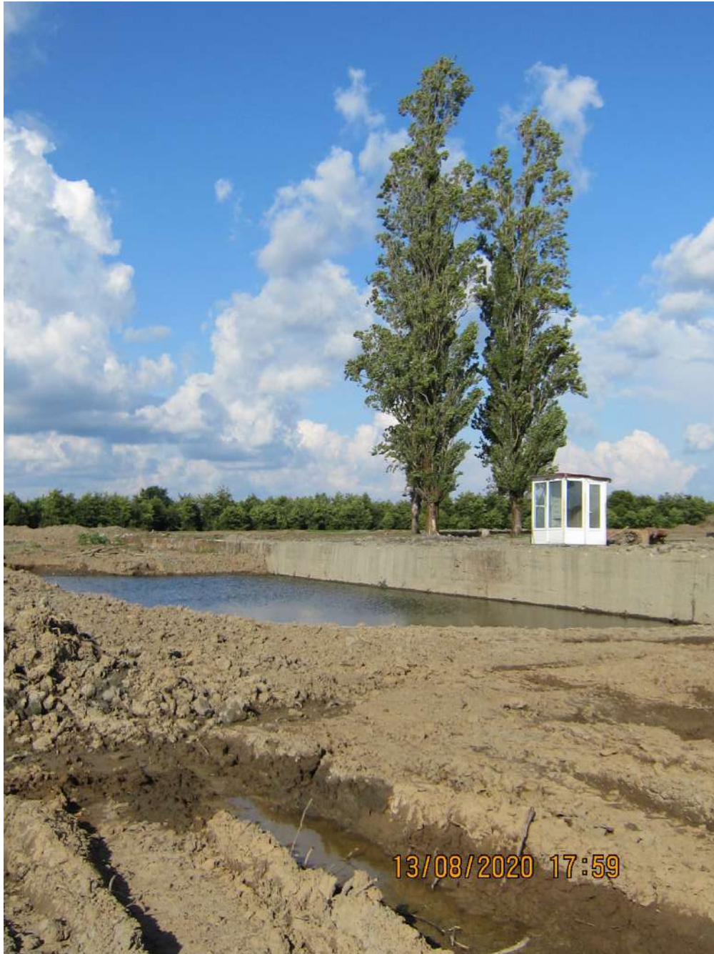
სურათი 4. ბოლვერკის ტიპის ნავსადგომი სამშენებლო ტერიტორიაზე
