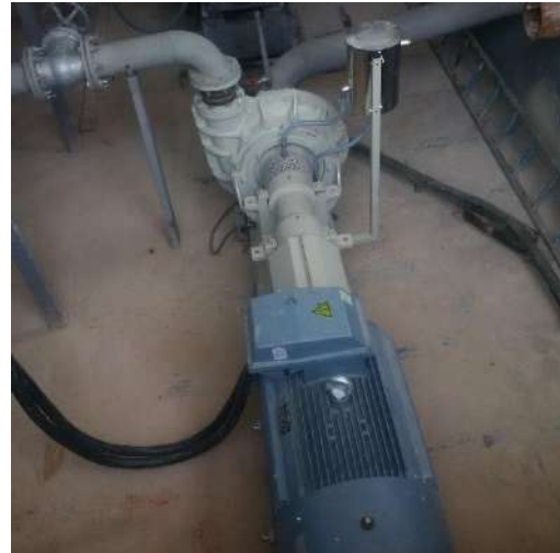
ნახაზი 5.6.1. შებრუნებული წყლის არსებული ტუმბოები (RMG Copper-ის არსებული კუდსაცავი)
