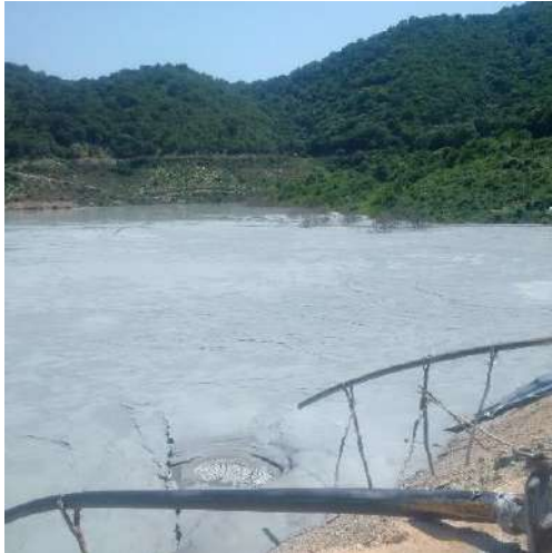
ნახაზი 5.2.1. შეუსქელელებელი პულპის დამბის თხემიდან ჩაშვება – არსებული კუდსაცავი
