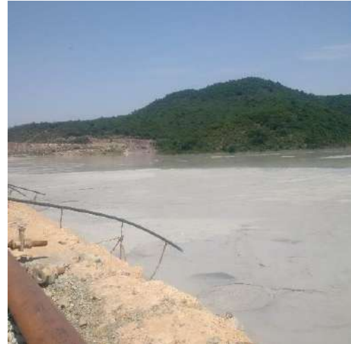
ნახაზი 5.2.1. შეუსქელელებელი პულპის დამბის თხემიდან ჩაშვება – არსებული კუდსაცავი
