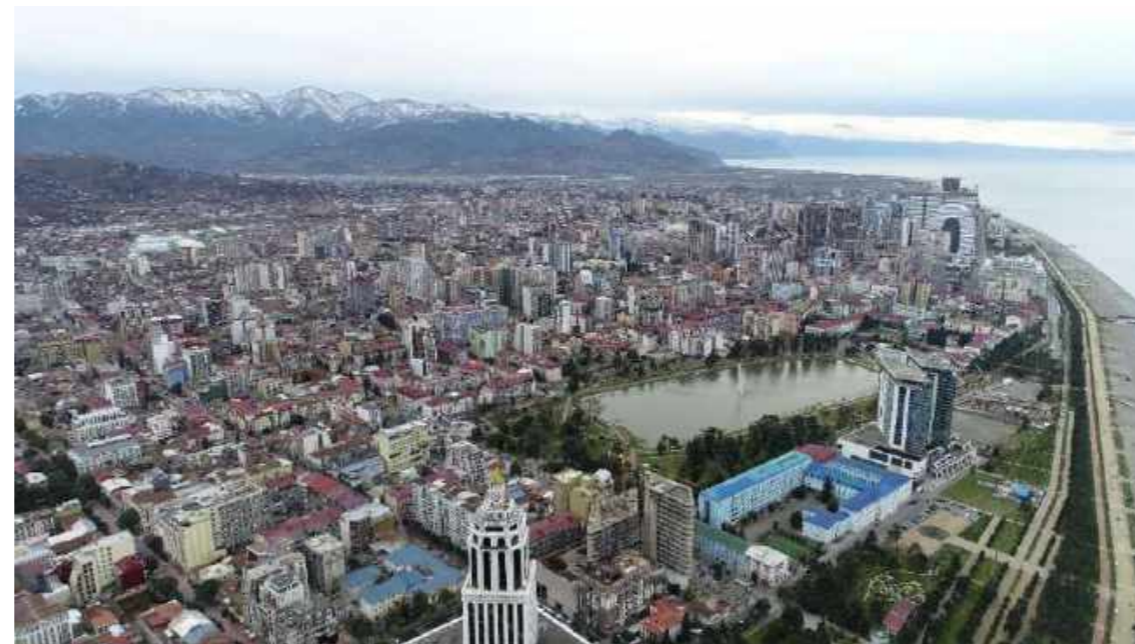
ხედი საპროექტო ტერიტორიებზე. 2018 წლის აეროფოტო.
