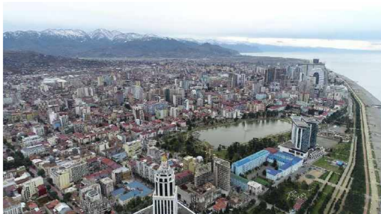
ხედი საპროექტო ტერიტორიებზე. 2018 წლის აეროფოტო.
