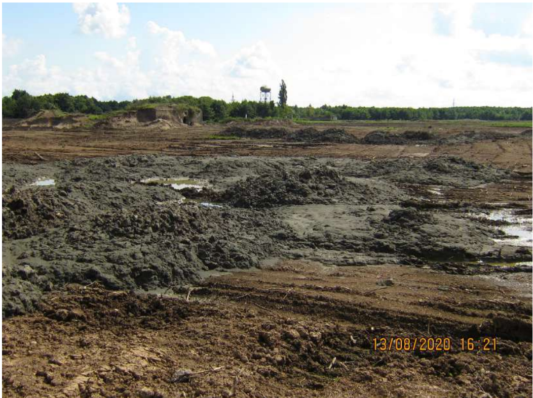
სურათი 8. სამშენელო ტერიტორიის გადათხრილი მონაკვეთი
