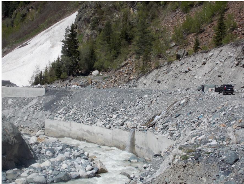
ნახაზი 2.1.3.1. შესრულებული გამაგრებითი სამუშაოების სქემა- გალერეის ზედა დინებაში
