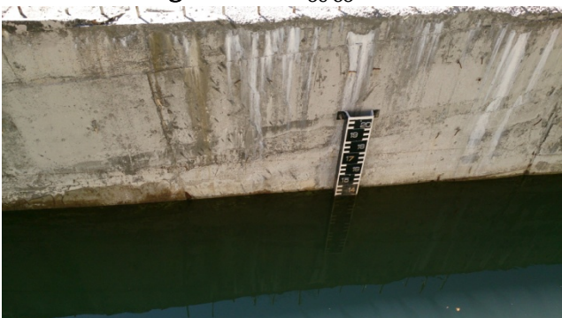
სურ. 3.1.3. სათავე კვანძზე დამონტაჟებული წყალმზომი
