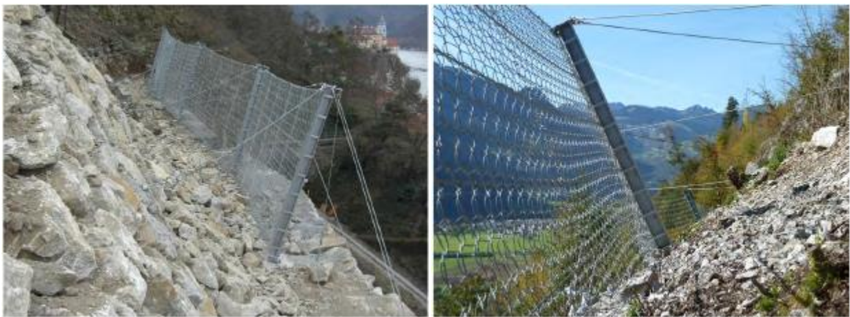
სურ. 12-1: ტექნიკური ჩამოშლისგან დამცავი ზღუდე (2,000 kJ) კაშხლის ნაპირზე. სურათი 12-2: ტექნიკური ჩამოშლისგან დამცავი ზღუდე (2,000 kJ) ბუნებრივ ფერდობზე.
