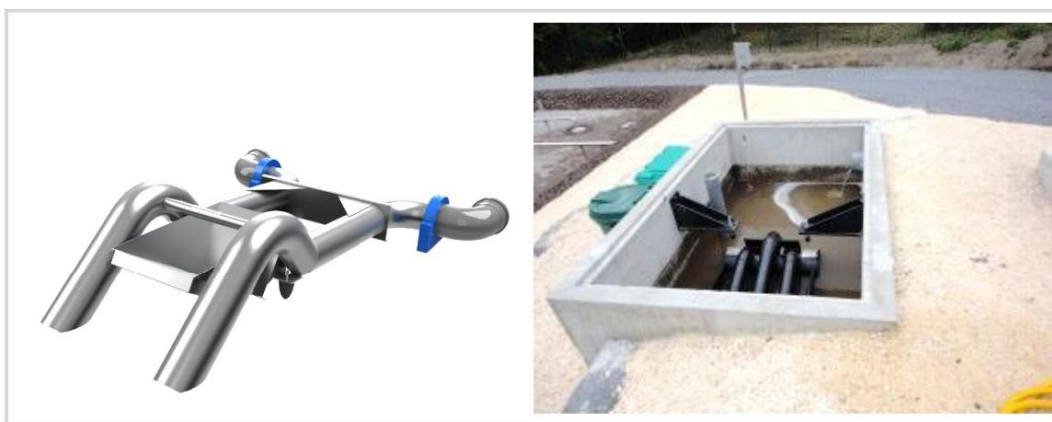
სურათი 2.4.1. ავტომატური რეგულირების სიფონი
