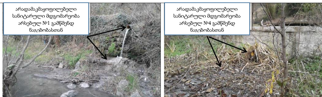
სურათები 7.6.1. დაბა შუახევში საკანალიზაციო სისტემების არსებული მდგომარეობა
