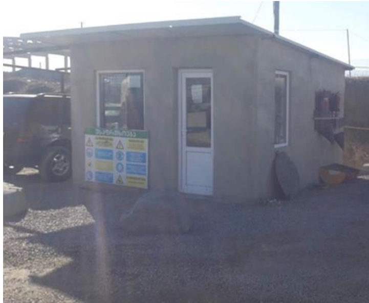
სურ. 10 - ხანძარსაწინააღმდეგო სტენდი საწარმოს ტერიტორიაზე
