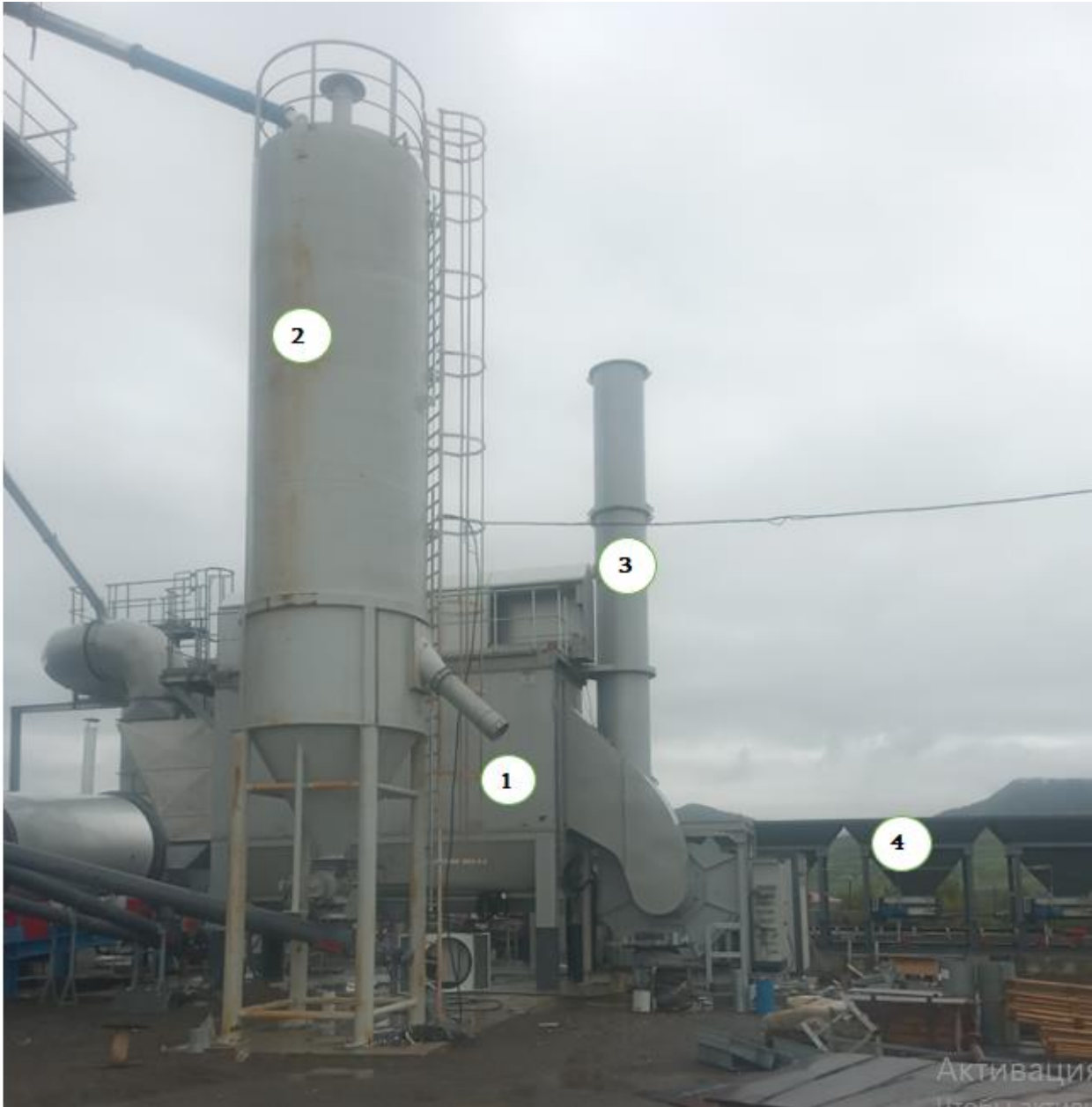
1. სახელოიანი ფილტრი; 2. მინერალური ფხვნილის სილოსი; 3. სახელოიანი ფილტრის მავნე ნივთიერებათა გაფრქვევის მილი; 4. საშრობი დოლის მკვებავი ბუნკერი.
