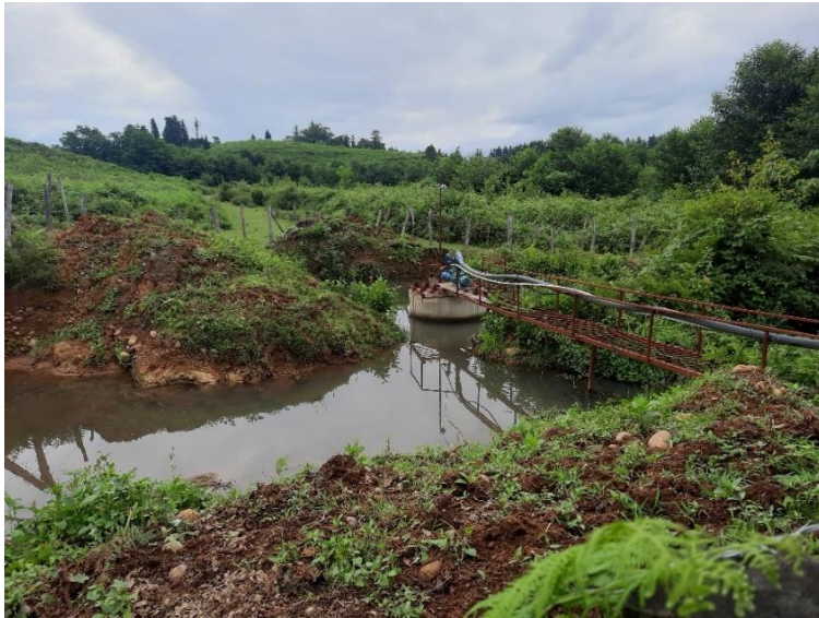
სურათი 4.6. წყალმიმღები გუბურა და ტუმბო
