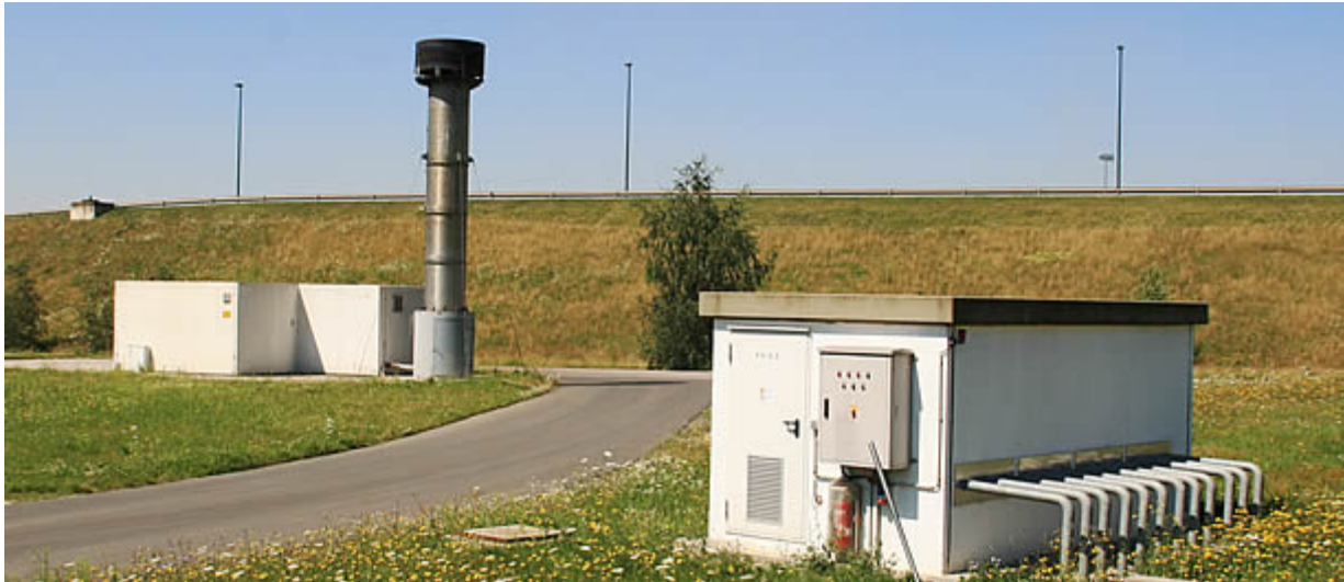
სურათი 3-8. ქვესადგური და ჩირაღდანი (გამაძლიერებელი სადგურის ჩათვლით)
