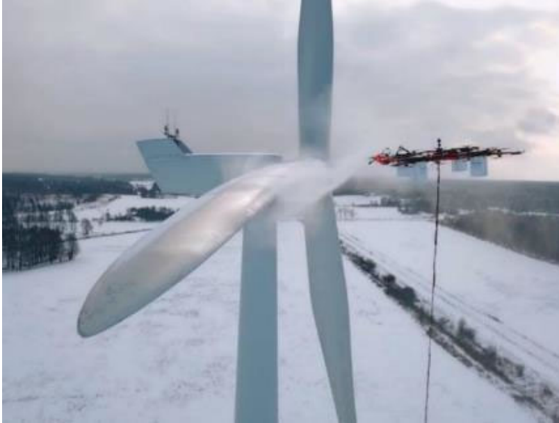
სურათი 6-9 დროს გამოყენება ქარის ტურბინის გასაწმენდად
