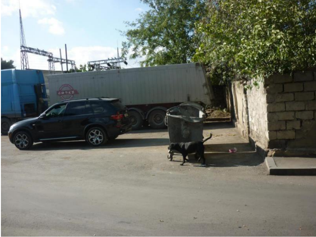
სურათი #29. ხედი დასავლეთით. ბოლო მონაკვეთზე (7-8) საპროექტო ტრასა კვეთს 7 მ სიგანის გზატკეცილს და კედლის გაყოლებით აღწევს ბოლო წერტილამდე – „მცირე ნავთლულის“ მაღალი ძაბვის ქვესადგურამდე.
