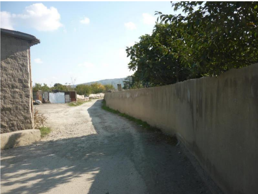
სურათი #26. ხედი სამხრეთით სამგორის ქუჩის მიმართულებით რომელიც ამ მონაკვეთზე 5 მ სიგანის გაუმჯობესებულ გრუნტის გზას წარმოადგენს. საპროექტო ხაზი გატარდება ვაკისის განაპირა ნაწილით (სურათზე მარჯვენა მხარე). 1 მ-მდე ლითოლოგიური ჭრილი წარმოდგენილია ზედაში – ტექნოგენური გრუნტებით – ხრეშით, ქვიშნარით, თიხნარით, ხოლო ქვედაში დელუვიურ-პროლუვიური (dpQIV) თიხნარებით, ნატეხოვანი მასალის გარკვეული პროცენტული ჩანართებით.
