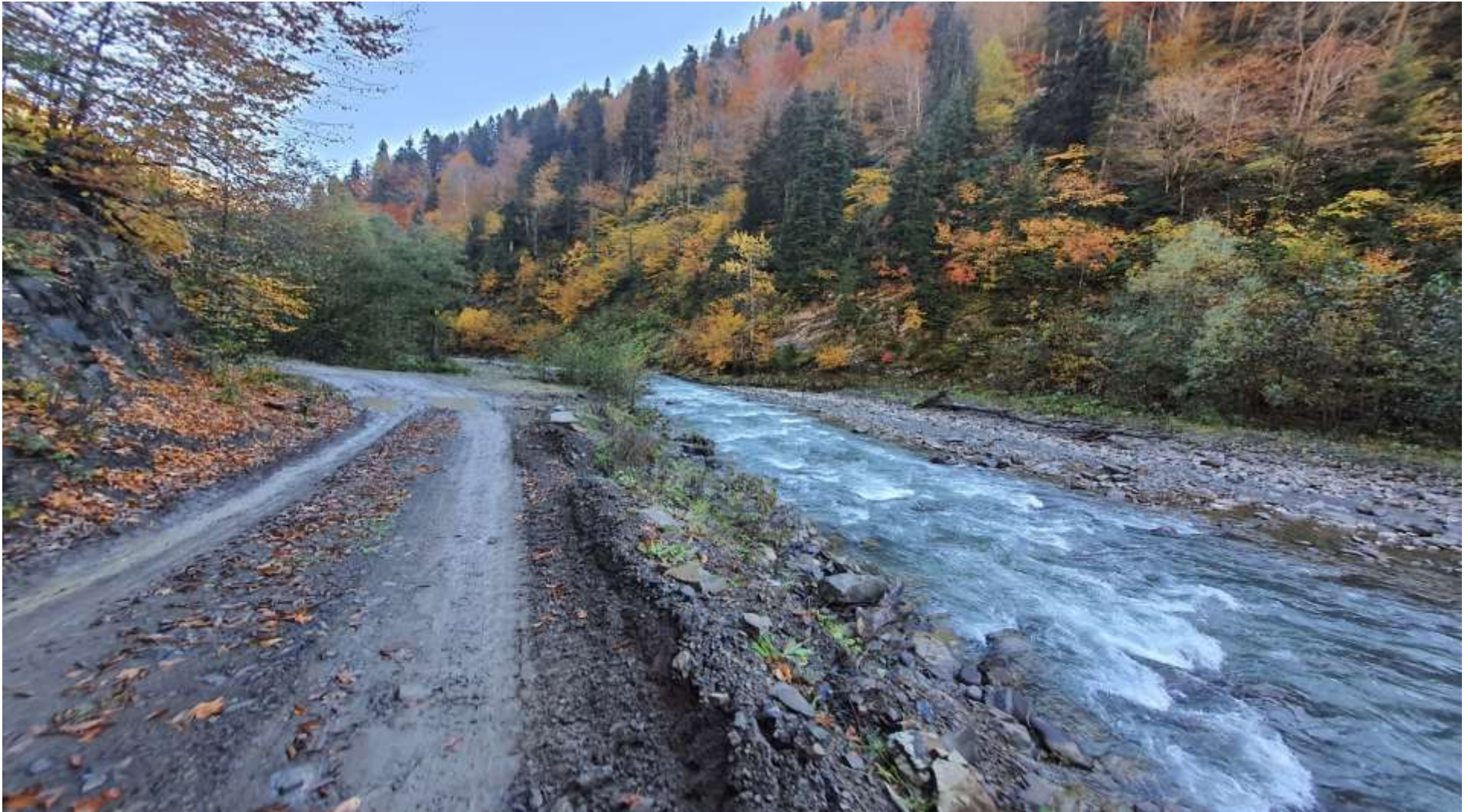
სურ. 2.1.1.1-2.1.1.2 სათავე ნაგებობის მიმდებარე ტერიტორია
