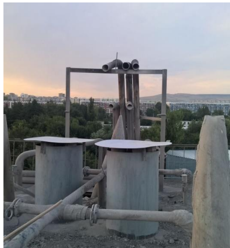
სურათი 2.1.7. სილოსების ფილტრები
