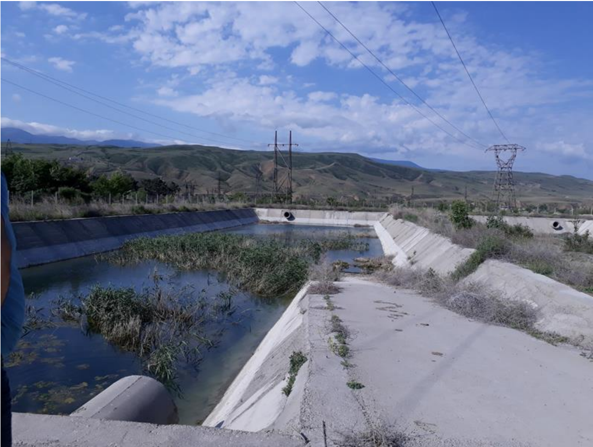
სურათი 26 კასპის ცემენტის ქარხნის სანიაღვრე წყლის გამწმენდი სალექარი
