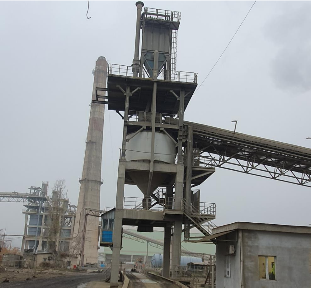
სურათი 13 კლინკერის ავტომობილებში ჩატვირთვის კვანძი
