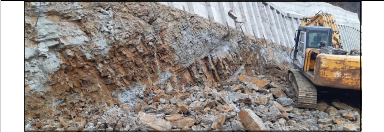
დაკვირვების წერტილი #18. ბეტონის ანკერირებული კედლის ორი რიგი და კარბონატული (მერგელოვანი) ქანების წყება (ასევე გამაგრდება ბეტონის კედლით).
