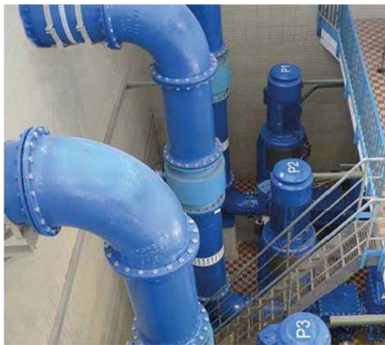
სურათი 8: შემშვები სატუმბო სადგური
