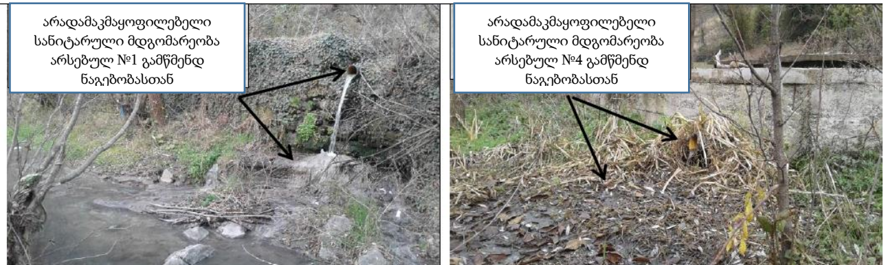
სურათები 7.6.1. დაბა შუახევში საკანალიზაციო სისტემების არსებული მდგომარეობა
