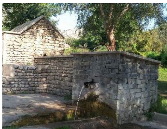
სურ.4-5. დაკაპტაჟებული წყაროები (მცხეთა-მთიანეთისა და კახეთის მხარეები)
