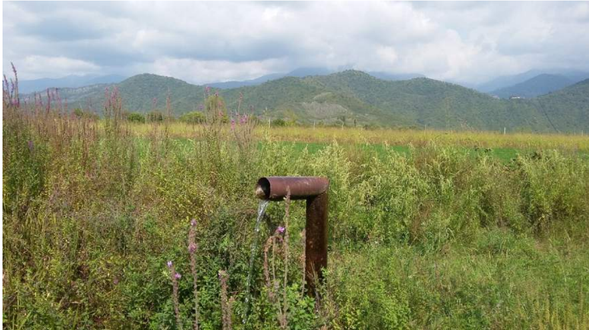
სურ.32. ერთ-ერთი თვითმდენი ჭაბურღილი ალაზნის არტეზიულ აუზში, ყვარლის მუნიციპალიტეტის სოფ. წიწკანანთსერის ტერიტორიაზე
