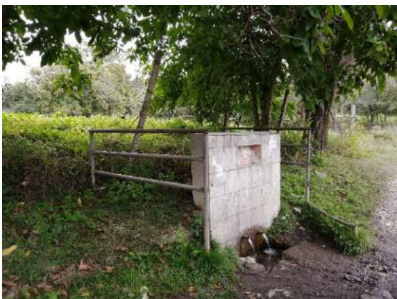
სურ.4-5. დაკაპტაჟებული წყაროები (მცხეთა-მთიანეთისა და კახეთის მხარეები)
