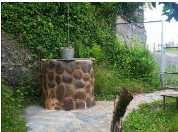
სურ.2-3. მოპირკეთებული საყოფაცხოვრებო ჭები (გურიის მხარე)
