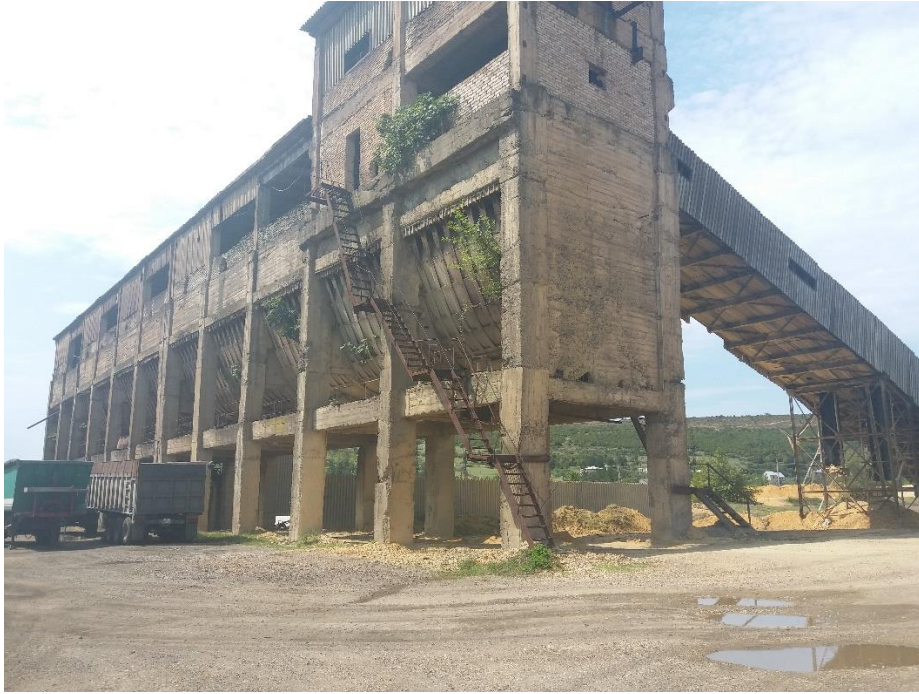
სურათი 2.2. ჯორჯიან მანგანეზის ტერიტორია
