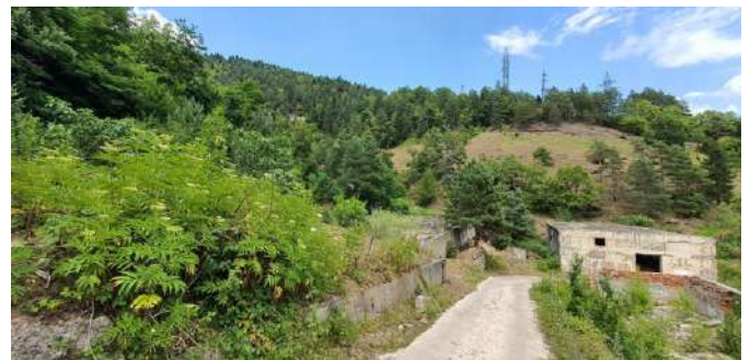
(ე) ტერიტორიაზე არსებული შენობა ნაგებობები
