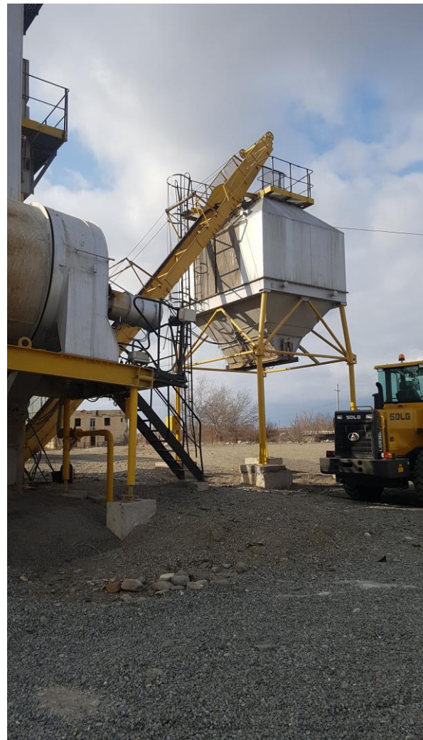
სურათი 3.2.4. ინერტული მასალების მიმღები ბუნკერები
