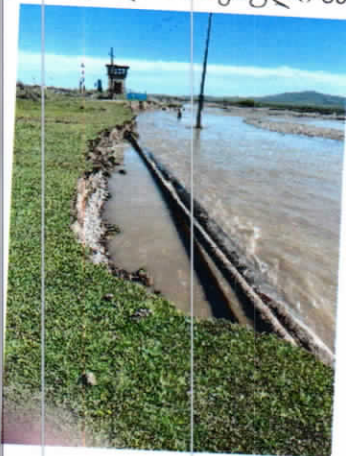
წყალდიდობის შედეგად დაზიანებული წყალმომარაგების ინფრასტრუქტურა
